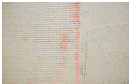
IN FASE DI POSA
